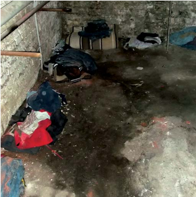
Abb. 7: Lager im Keller eines Wohnhauses
